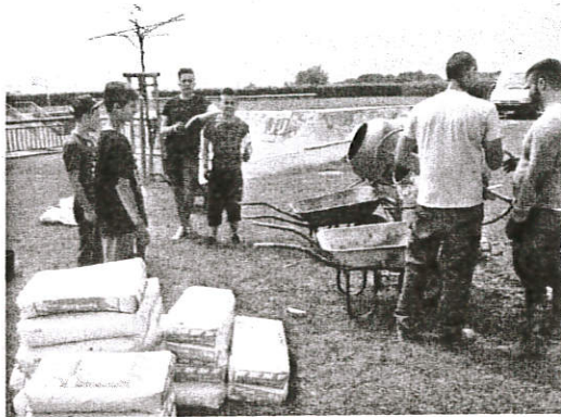
Die Bauarbeiten laufen. Foto: Christian Mayer
